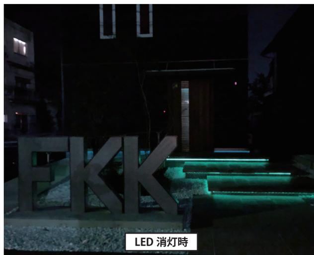
ルミナスギャラリー外構には蓄光照明を多数設置。人感センサー制御で、LED 点灯時には明るく照明、消灯時でも光（燐光）が継続する事によって視界を確保し続けます。
